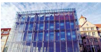
→ vue extérieure du ZKM
