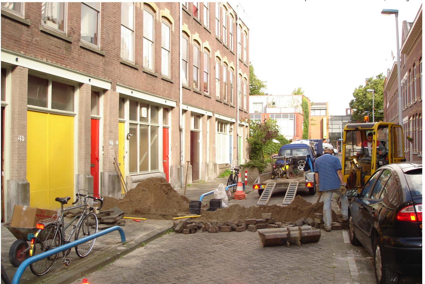
Wolphaertstraat under construction, Stichting NAC
